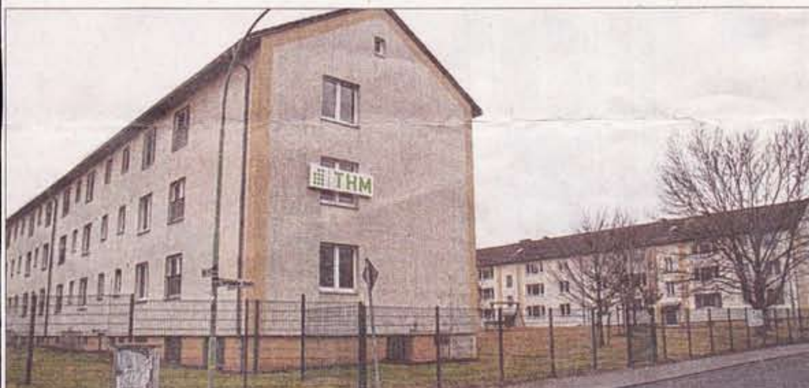
Die Wohnblocks der Housing Area – im Bild ein von der Technischen Hochschule erworbenes Gebäude – werden fast komplett abgerissen.
